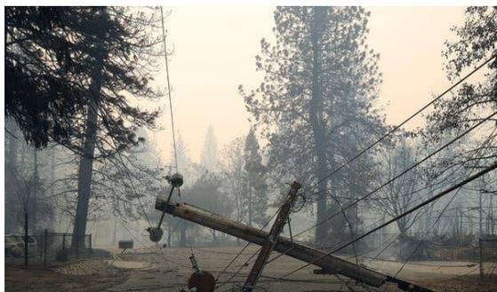
Figure 2 - Réseau aérien de télécommunication détruit en 2021 en Californie
